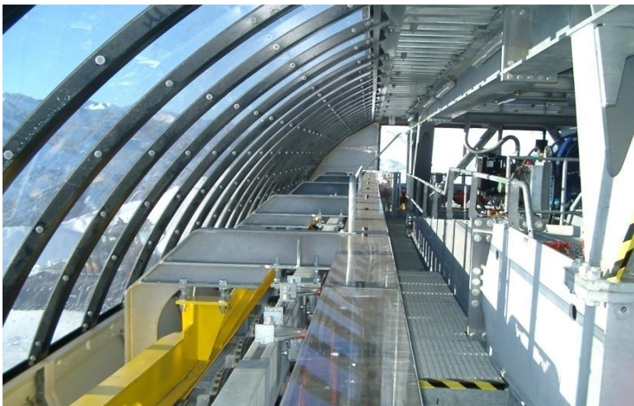
Рисунок 38. Терминал станции (вид изнутри)
