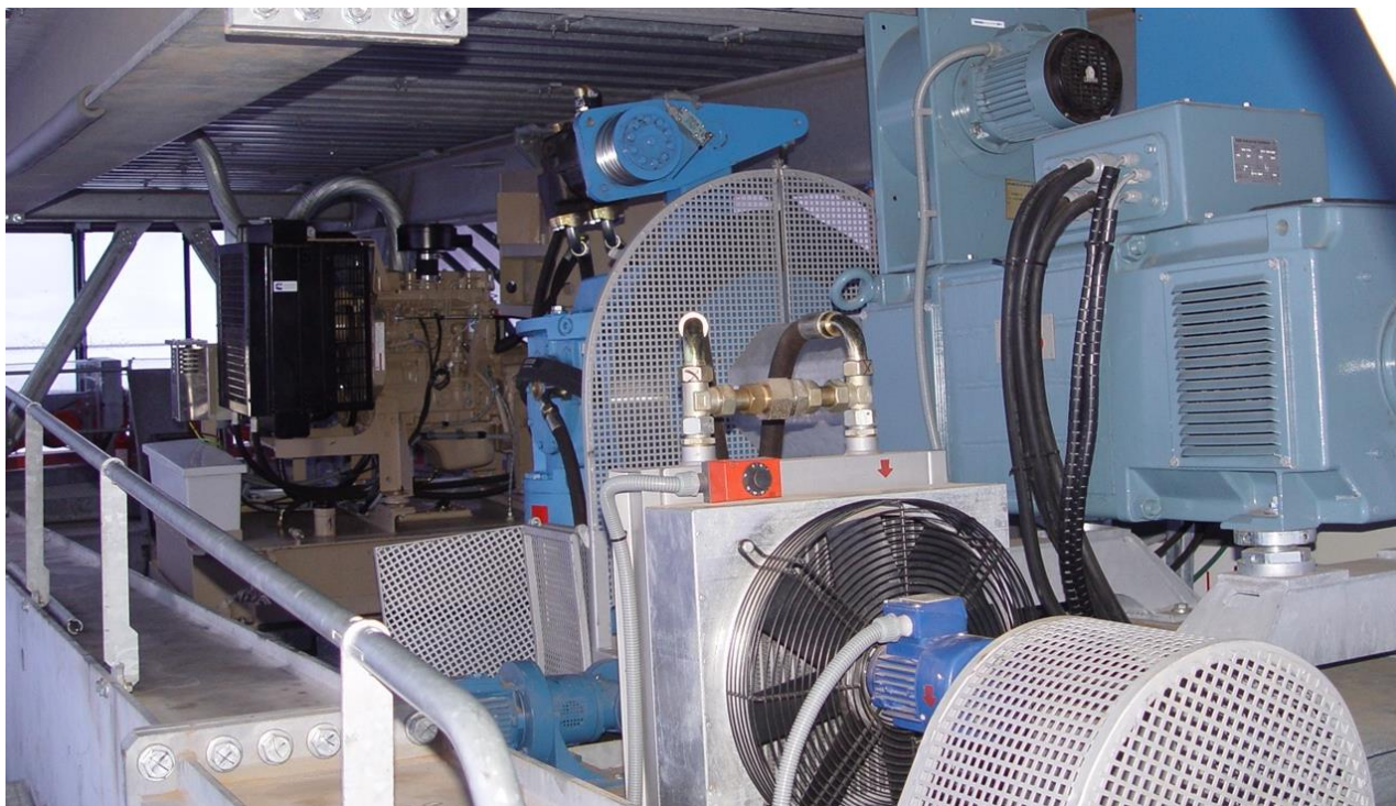
Рисунок 27. Главный привод канатной дороги
