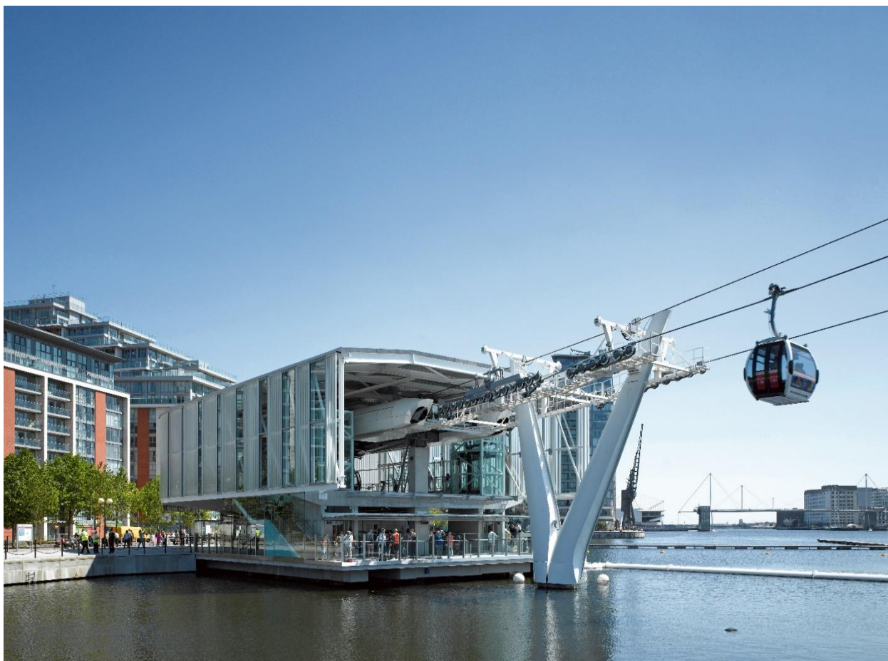
Рисунок 37. Терминал станции (вид снаружи)
