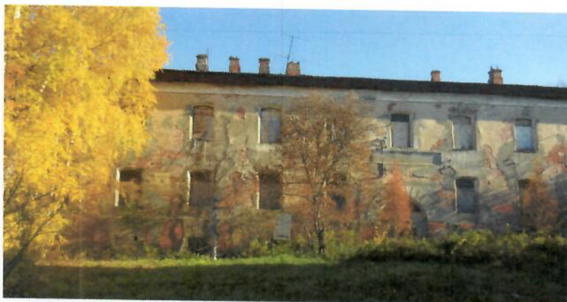
Фото фрагмента фасада с привязной к месту установки информационной таблички.
