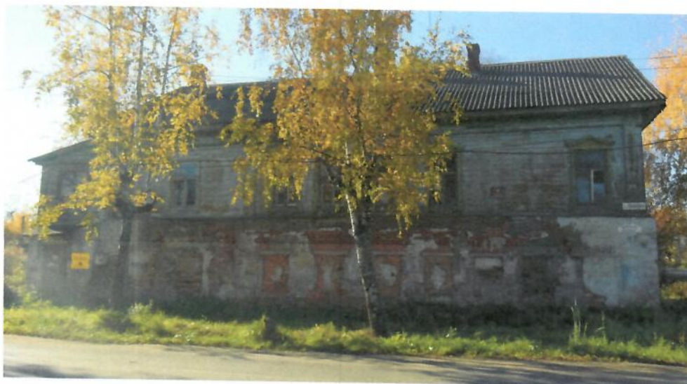
Фото фрагмента фасада с привязной к месту установки информационной таблички.
