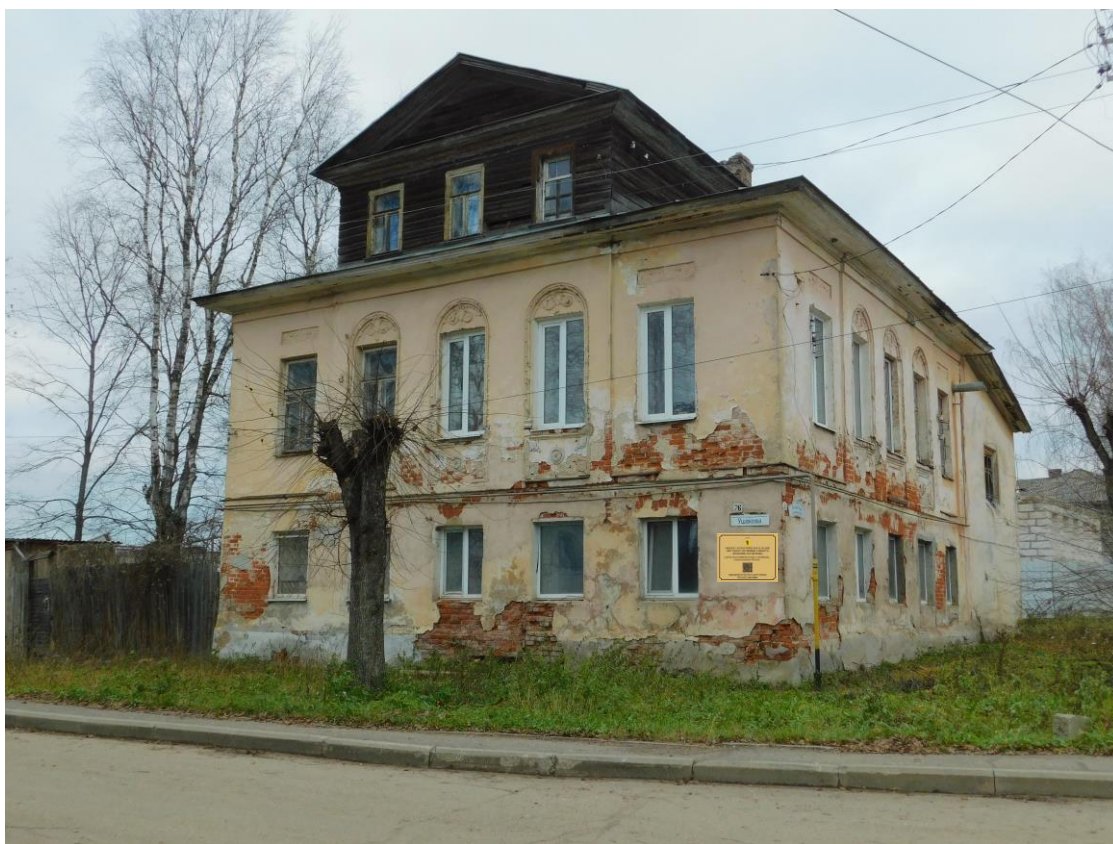
Фото фрагмента фасада с привязной к месту установки информационной таблички.
